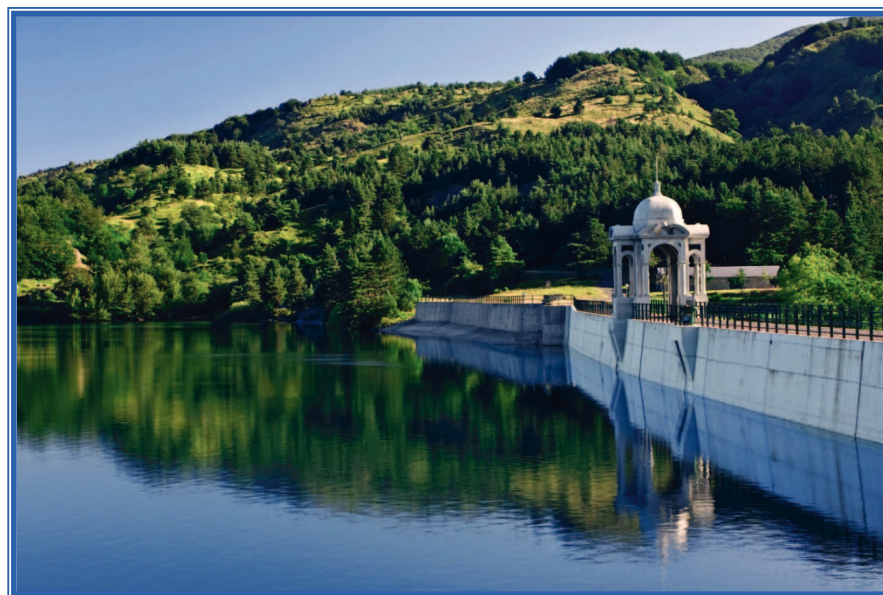
Nucleo idroelettrico di Genova, Diga di Osiglietta
